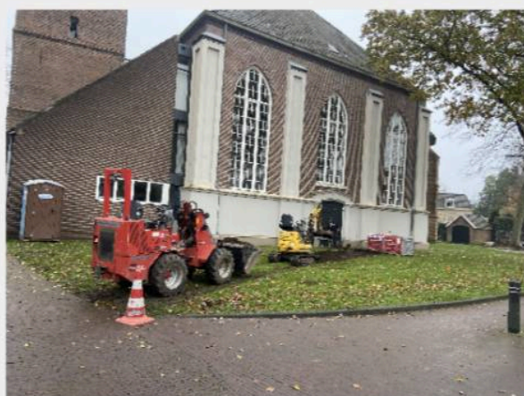
Aanleg van het pad vanaf het kerkplein naar het zuiderblok
